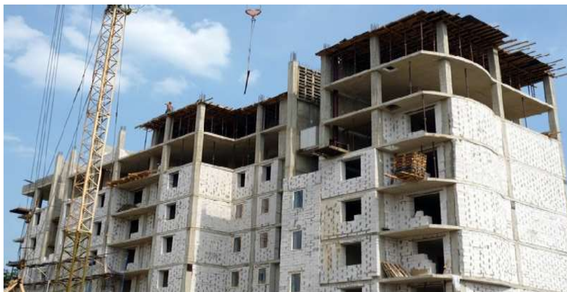
Рисунок 2. Многоквартирный жилой дом с монолитным каркасом и заполнением из газобетона.
