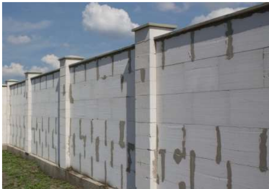
Рисунок 3. Забор из газобетонных блоков.
