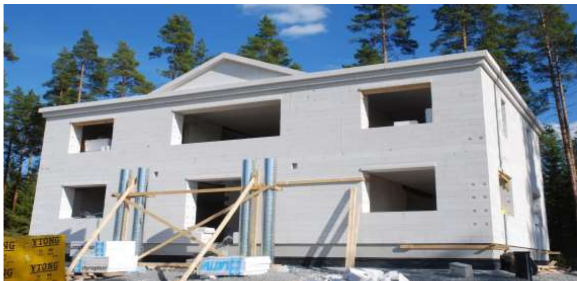
Рисунок 1. Жилой дом с несущими стенами из газобетона.
